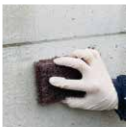
①コンクリート表面に下地処理
