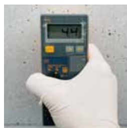
②塗布の可否判定 素地の表面含水率の確認
