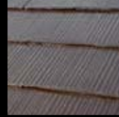
住宅屋根用化粧スレート
