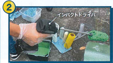
①をお手持ちのインパクトドライバに装着します。
