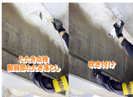
コンクリート剥落部の再剥落を防ぎます
