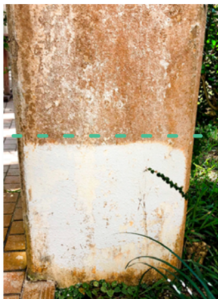
外壁面に発生した カビ・コケ・藻を除去
